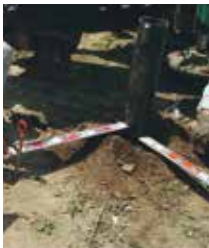
⑥ 施工完了（杭頭スレ確認）
