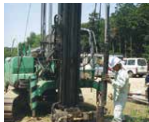
⊕α(1) 杭先端部モンケン落下
