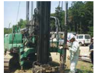
⊕α(1) 杭先端部モンケン落下
